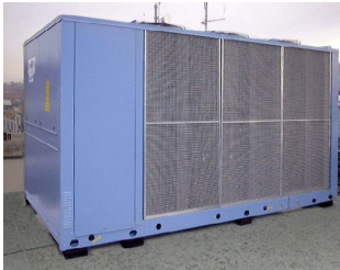
Appui du groupe frigorifique avec compresseur frigorifique et échangeur thermique avec support MAXUM
