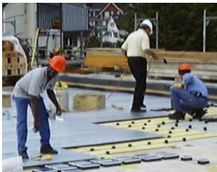
Travaux de pose d'une assise de bâtiment avec support MAXUM
