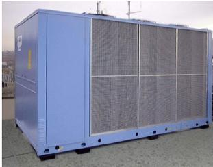
Lagerung Kaltwassersatz mit Kältekompressor und Wärmetauscher mit MAXUM Auflager
